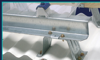
Entretoise MODULTOG Rénovation de tôles ondulées galvanisées P. O. 76 x 18.
